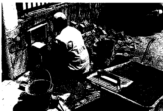
Ligações à rede de água
