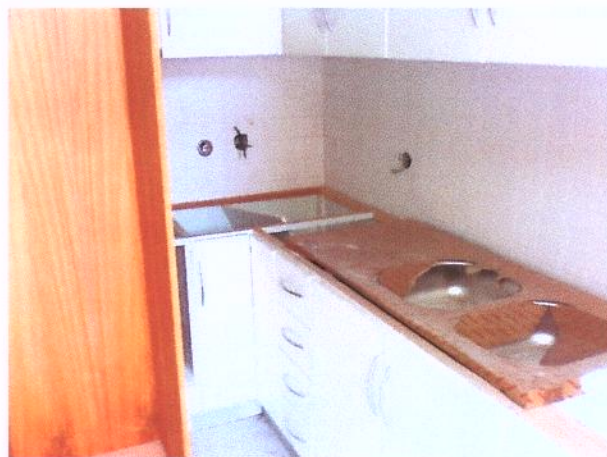
Loteamento Urbano de Milhazes – Vista pelo Interior
