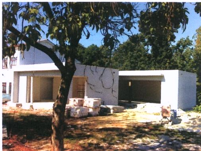
Ampliação da Escola EB1 de S. Brás – Barcelinhos
