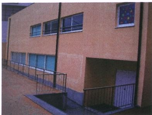
Construção do Jardim-de-Infância de Oliveira
