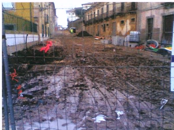
Requalificação Urbana da Rua Cónego Joaquim Gaiolas
