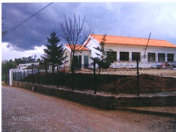
Cantina da Escola de Encourados
