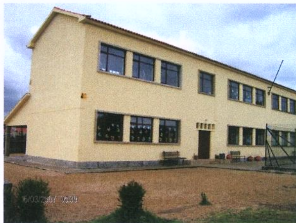
Ampliação da Escola Primária de Martim.
