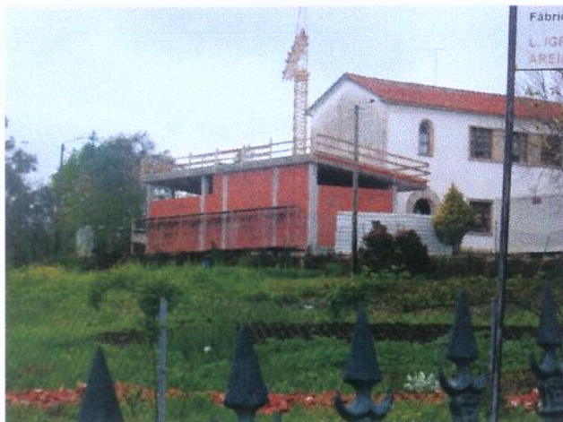
Ampliação da escola Primária de Areias de S. Vicente – 2ª Fase
