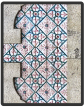
04 Façade près du Temple du Senhor Bom Jesus da Cruz, avec des carreaux en relevés attribuables à la Usine de Santo António do Vale da Piedade.
